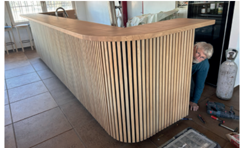
Tischlermeister Friedrich Feuerhake beim Aufbau der neuen Theke kurz vor der Fertigstellung.
