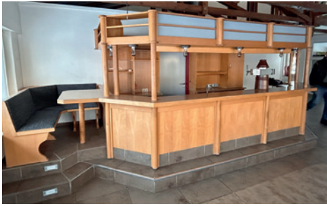
Die alte Theke vor dem Umbau. Was lange gut aussah, war technisch längst überholt.
